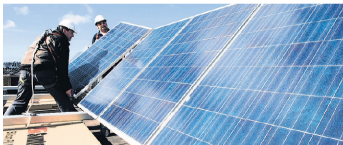
Zonnepanelen op de daken van twee basisscholen en een buurt-huis moeten de woningen in Biesland van energie gaan voorzien. Dit vergoederde plan is onderdeel van een groter buurtproject. Zo heeft de bewonersvereniging het voortouw genomen om de woningen energiezuiniger te maken. ARCHIEFFOTO
